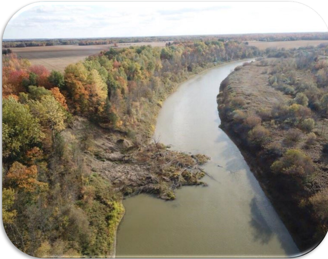
Affaissement en aval du ruisseau Wolf, La Nation, automne 2018.
