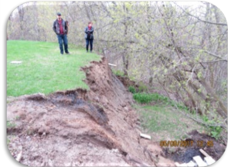
Glissement de terrain à petite échelle suite à la construction d'un garage non autorisé, 2017.
